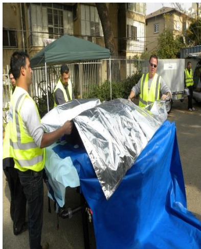
מיכל 2 מ"ק בהליך הרכבה
